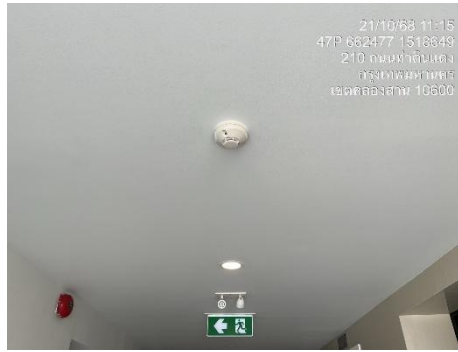
รูปที่ 51 เครื่องตรวจจับควัน ภายในห้องเครื่องไฟฟ้า
