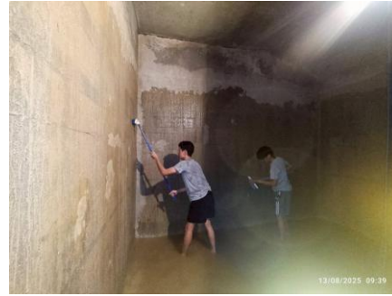
รูปที่ 61 ล้างทำความสะอาดถังสำรองน้ำใช้
