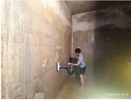
รูปที่ 61 ล้างทำความสะอาดถังสำรองน้ำใช้
